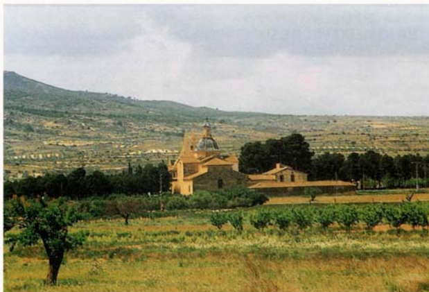
VISTA PANORAMICA POSTERIOR DEL COMPLEJO VIVIENDA-IGLESIA
