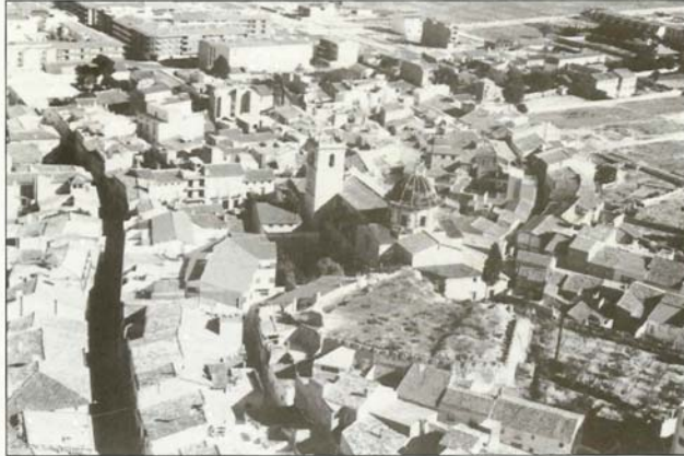
Vista aérea fachada oeste de la fortaleza de Caudete. Foto Molina - Caudete
