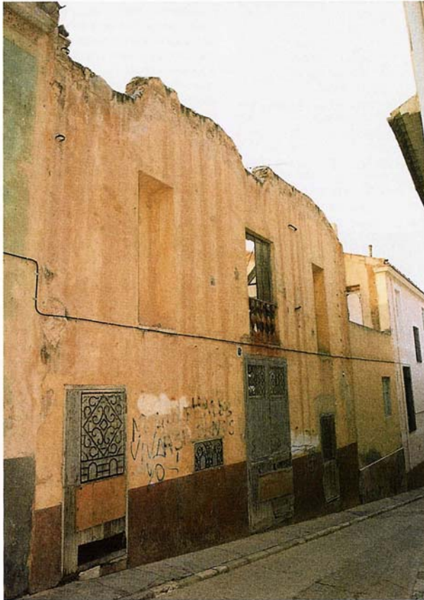
Estado actual de la fachada principal
