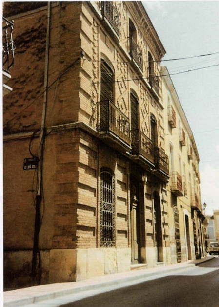
CALLE MAYOR. Casa con fachada principal de ladrillo macizo.
